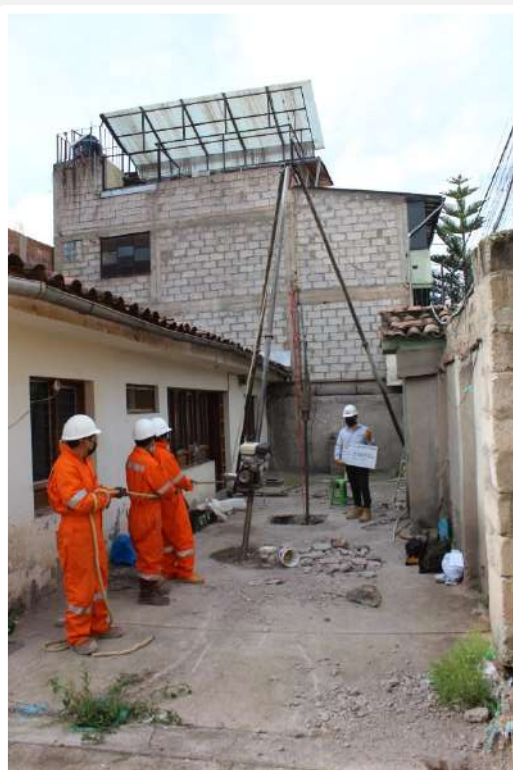
Ensayos SPT Edificación
