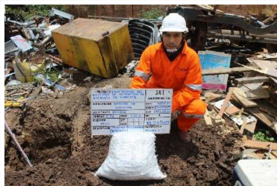
Recuperación de muestra para CBR
