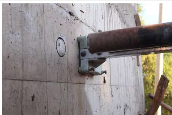
Extracción de Cores de concreto por perforación diamantina
