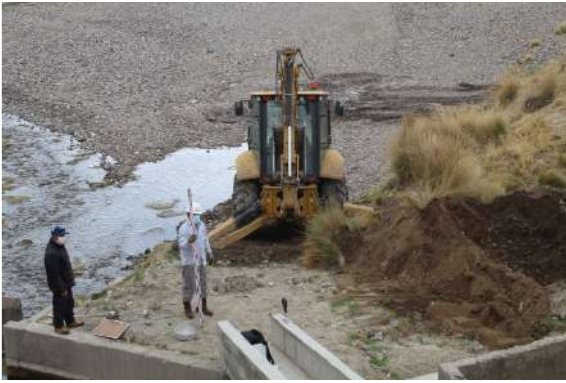
Estudios geotécnicos para proyectos de irrigación - Bocatoma
